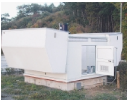
屋根が開いたところ
